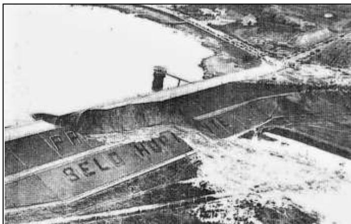
**Figura 3.6** – Vista da brecha no corpo da barragem da Pampulha (Fonte: VIANNA, 1997)
