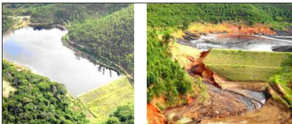
**Figura 3.9** – Vista da barragem de rejeitos da indústria Cataguases antes e depois da ruptura (Fonte: MENESCAL *et al.*, 2005b)
