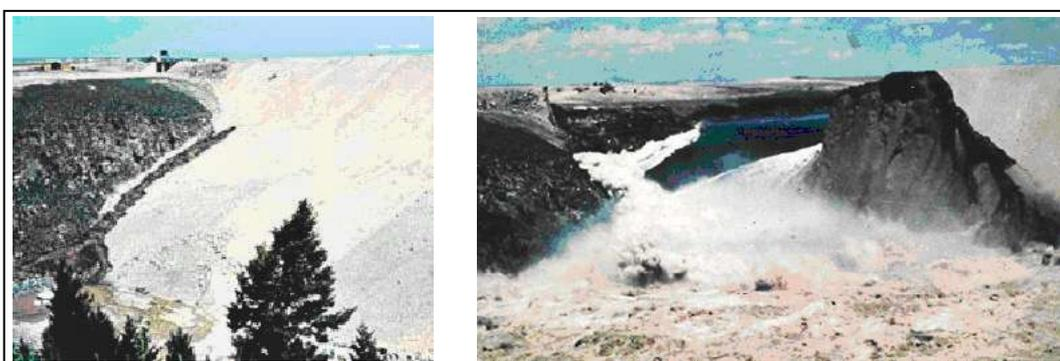
**Figura 3.5** – Vista da barragem de Teton indicando diferentes fases de formação da brecha (Fonte: U.S. BUREAU OF RECLAMATION, 2002)
