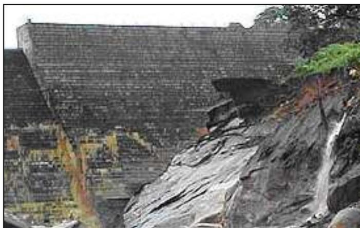
**Figura 3.10** – Vista da brecha no corpo da barragem de Camará (Fonte: MENESCAL *et al.*, 2005b)
