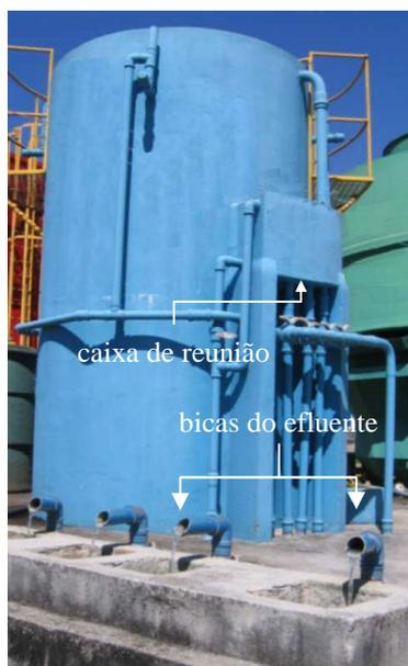
**Figura 6.1** - Vista do reator UASB, escala demonstração ( $R_{demo}$ )
