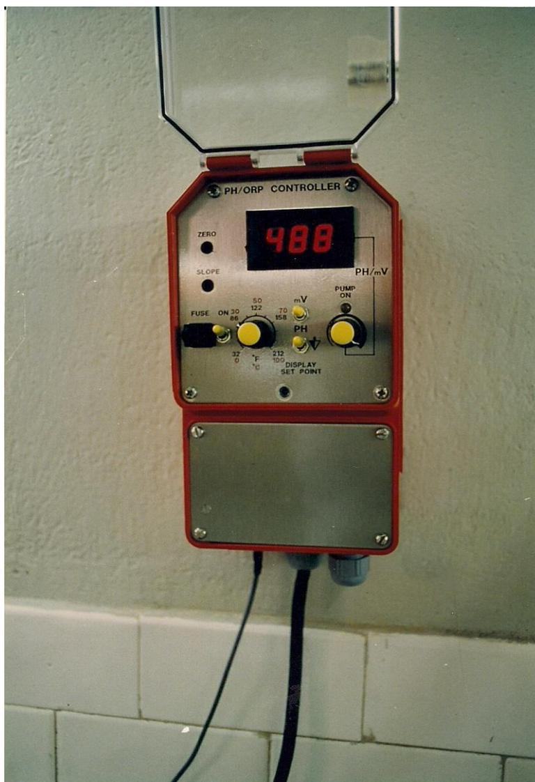
**Figura 3.1. Aparelho controlador de pH-ORP**
