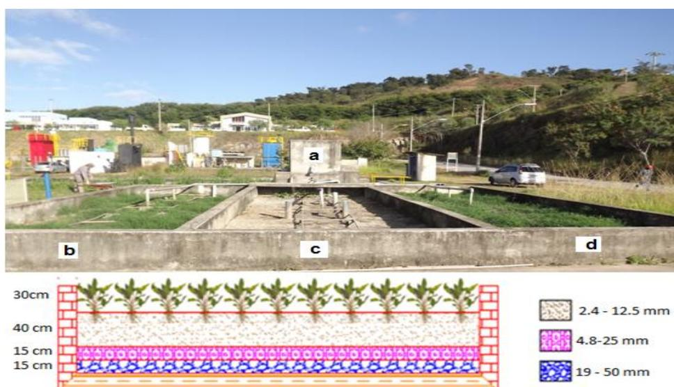
**Figura 4.3:** Vista geral do sistema de tratamento a ser estudado; (a) caixa de alimentação, (b) unidade plantada – UP, (c) unidade não plantada (controle) – UC, (d) unidade não monitorada.
