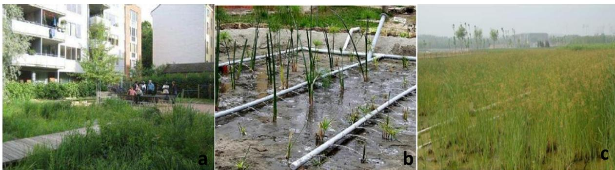
**Figura 3.1:** Exemplos da aplicação de SAC no mundo. (a) tratamento de água cinza em área urbana com SAC subsuperficial em Oslo, Noruega (Foto: L. Urich, 2008); (b) SACV em construção durante o teste de uniformidade de distribuição em Lima, Peru (Foto: H. Hoffmann, 2008); (c) SACV tratando esgoto doméstico no Olympic Forest Park em Pequim, China (Foto: L. Germer, 2008).
