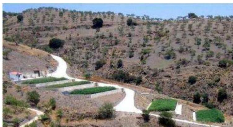
**Figura 3.5:** SAC do tipo francês construído em Albodón, Espanha, com três leitos no primeiro estágio tratando esgotos brutos e dois no segundo estágio para pós-tratamento.
