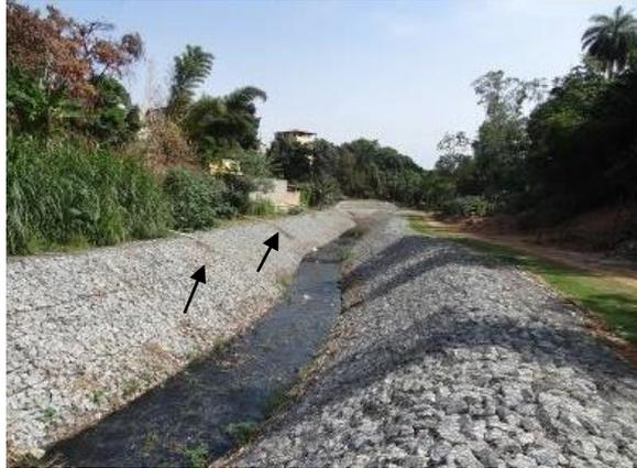
**Figura 8-31:** Trecho em gabião, lançamentos de esgoto direto das casas das margens
